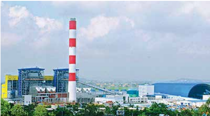
Nhà máy Nhiệt điện Mạo Khê - Quảng Ninh
